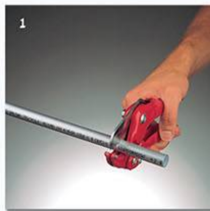
1 برش عمودی در لوله توسط قیچی مخصوص
